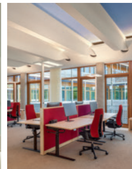
Die Büroflächen wurden mit bis zu 14 m weit spannenden Decken stützenfrei realisiert, um maximale Flexibilität zu erreichen.
