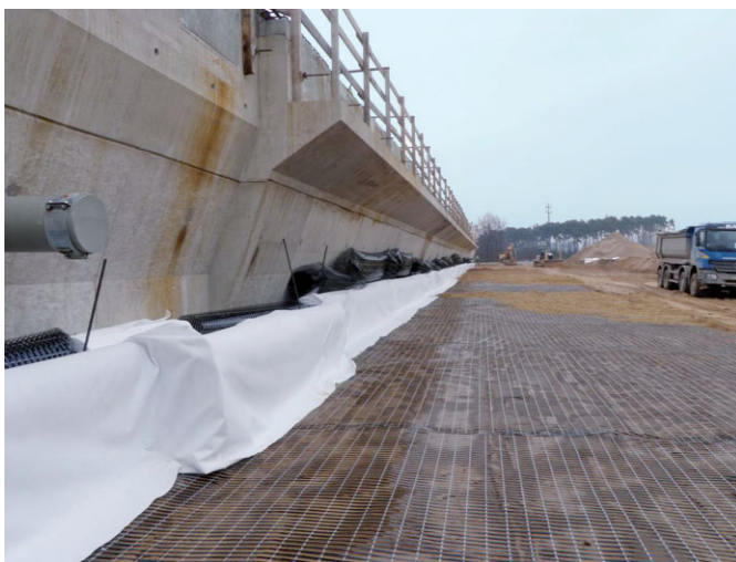
Bild 11. Erddruckfänger im Bau Fig. 11. Geogrid Reinforced Earth under construction
