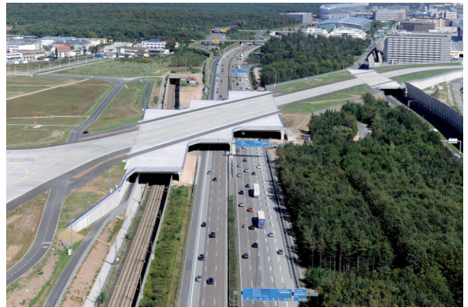
Bild 9. Rollbrücke Ost 1, Luftbild (© Fraport AG) Fig. 9. Taxiway Bridge East 1, air photo (© Fraport AG)
