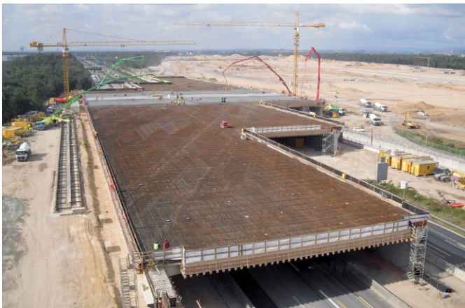
Bild 8. Rollbrücke Ost 1, Betonage der Brückenplatte in einem Gang Fig. 8. Taxiway Bridge East 1, concreting of the bridge plate in one operation
