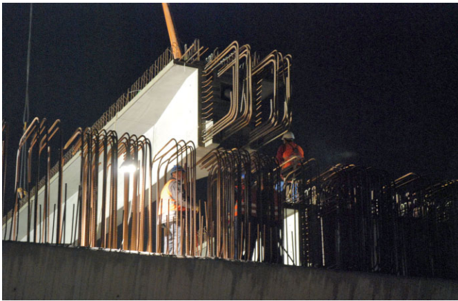
Bild 7. Rollbrücke Ost 1, Einfädeln der Bewehrung Fig. 7. Taxiway Bridge East 1, plaited reinforcement
