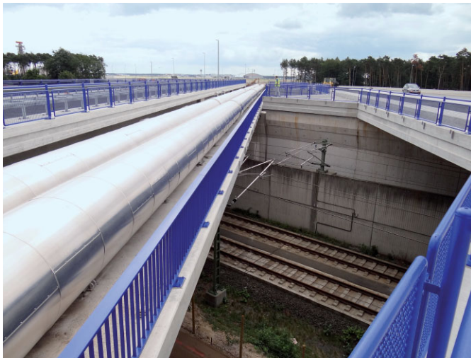
Bild 14. Rollbrücke West 1, Leitungsbrücke Fig. 14. Taxiway West 1, Line Bridge
