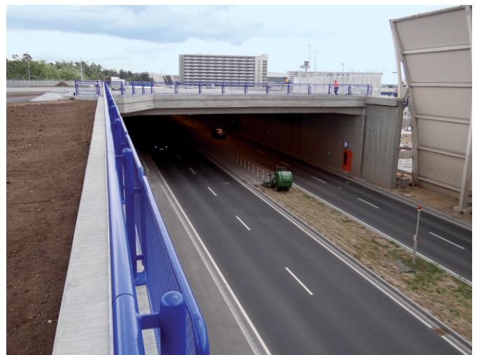
Bild 17. Rollbrücke Ost 2, Westportal Fig. 17. Taxiway Bridge East 2, West Portal
