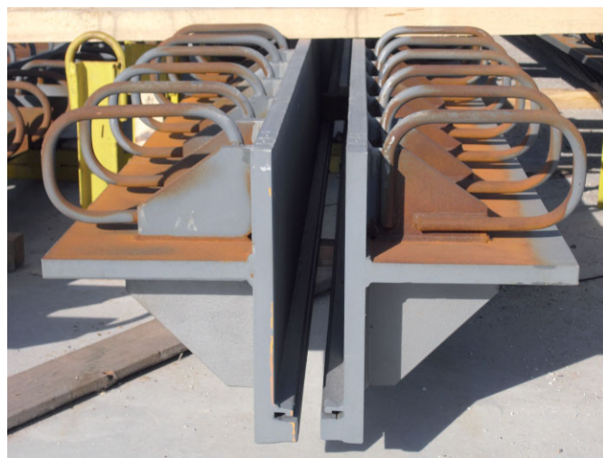
Bild 12. Dehnfugenkonstruktion bereit zum Einbau Fig. 12. Expansion joint ready for installation
